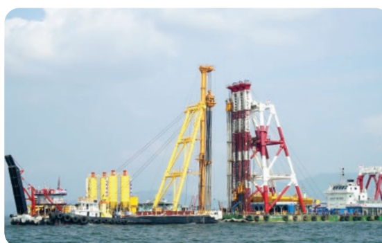
深層水泥拌合法工程船
